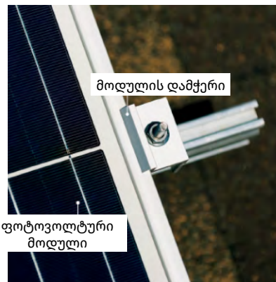
სურათი 2. ფოტოვოლტური მოდულის შუალედური დამჭერი
